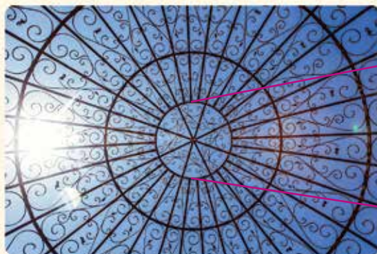
▪ Cúpula metálica vista desde abajo.
